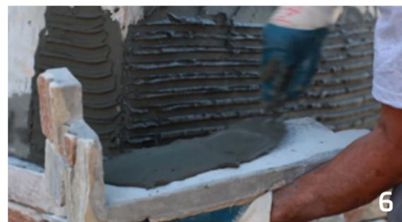
Aplicar também uma camada espessa de argamassa colante no verso do painel e distribuí-la horizontalmente com a ajuda duna talocha dentada de 6-7 mm. A argamassa utilizada deve ser C2 ou C2-S1/S2 para ambientes internos e C2-S1/S2 para ambientes externos.
