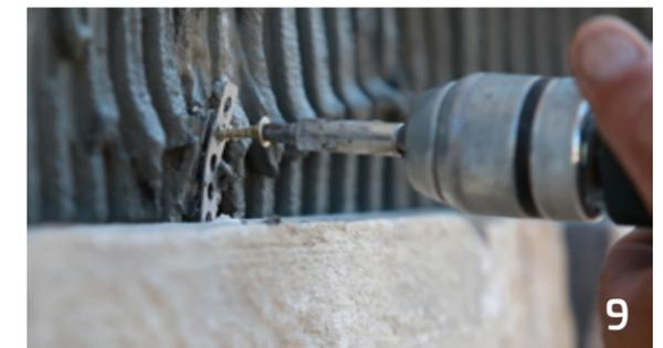
Insira o parafuso na faixa e fixe-o na parede. O STONEPANEL® vai caber bem.
