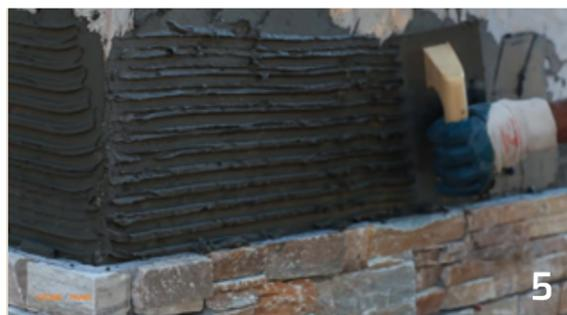
Com a espátula dentada, deve-se aplicar horizontalmente uma camada espessa e lisa de 6-7 mm de argamassa-cola. Para que a primeira fila fique nivelada, a instalação deve ser feita sobre uma ripa de metal ou sobre um pequeno perfil em L de aço inoxidável. A tira pode ser removida assim que a argamassa-cola secar e o perfil de aço inoxidável será integrado na instalação.
