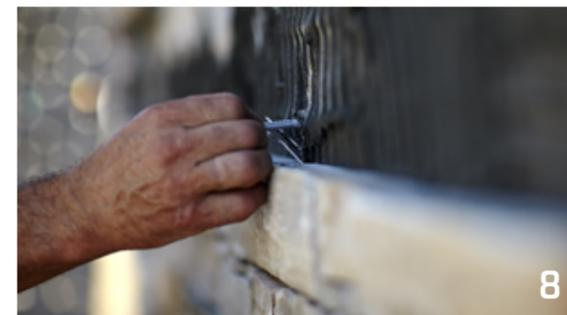
Cada painel requer fixação mecânica. Faça os furos para os parafusos de aço inoxidável e insira os pinos-guia na parede como auxiliares de fixação.
