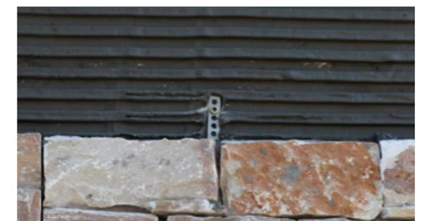
Siga o mesmo procedimento com o resto dos painéis da fileira y, de forma que a âncora mecânica fique totalmente coberta e não interfira na instalação dos painéis.
