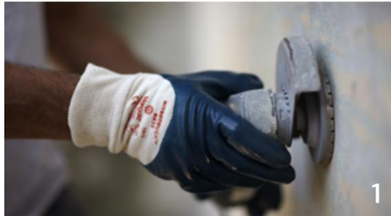
As paredes devem estar limpas e livres de filmes de poeira, sujeira, óleo, tinta, etc. Quaisquer rachaduras ou buracos devem ser preenchidos com argamassa de cimento. A parede suportará um peso acima de 100-110 kg/m<sup>2</sup>. O sistema só deve ser instalado quando não houver sinais de umidade na superfície, exceto aqueles causados por condensação.
