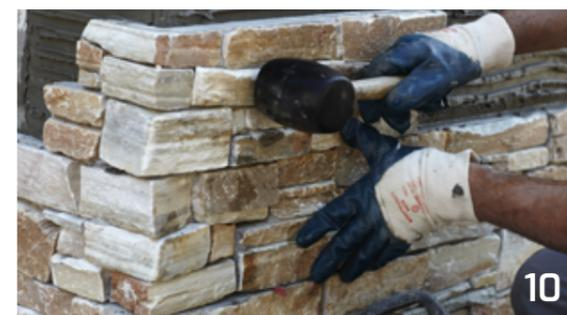
Após fixar o painel e aparafusá-lo à parede, deve-se bater com um martelo de borracha no mesmo para posicioná-lo e evitar bolhas de ar entre o painel e a parede e garantir a junção.
